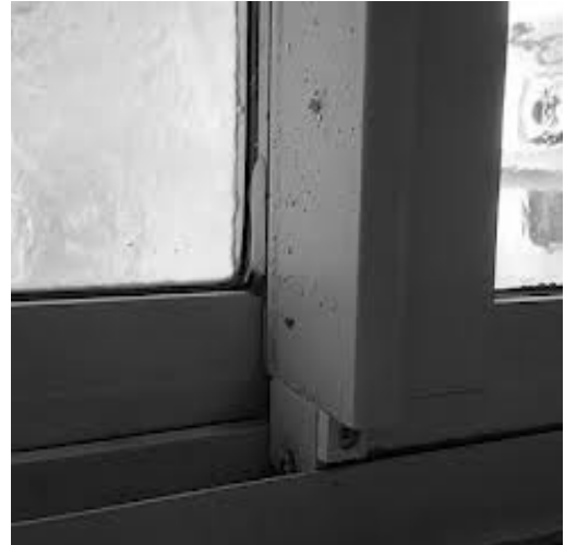
Hình 15.13: Lọt nước trên hệ vách kính
