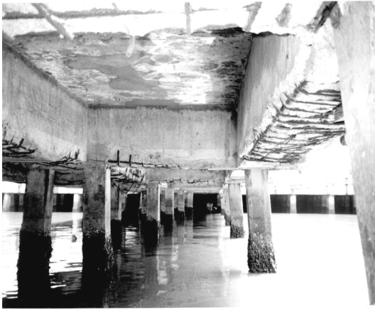
Hình 4.7: Ví dụ hiện trạng ăn mòn và hư hỏng cảng Thương vụ- Vũng Tàu sau 15 năm (khảo sát năm 2001)
