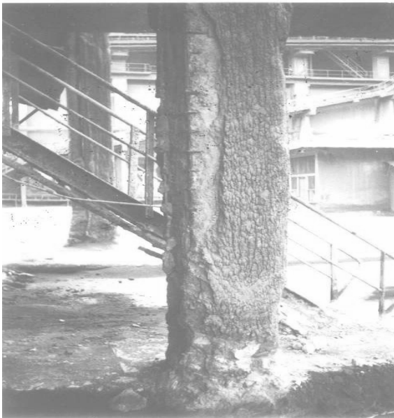
Hình 4.9: Ví dụ hiện trạng ăn mòn và hư hỏng nhà nghỉ Lê Lợi, Sầm Sơn, Thanh Hoá, cách biển 0,2 km
