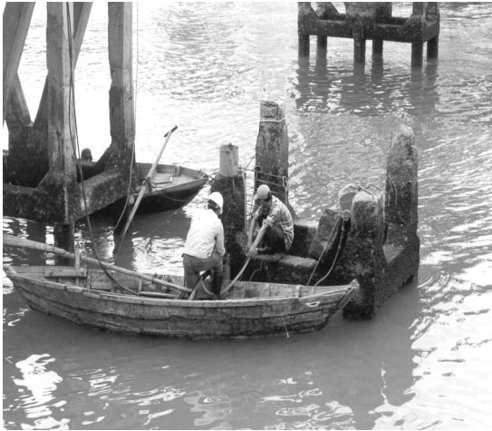
a) Phần dưới mặt nước bê tông còn tốt, cốt thép chỉ bị gỉ nhẹ
