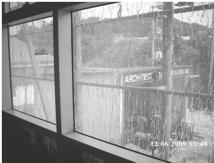
Hình 15.23: Thí nghiệm độ lọt nước (nhìn từ bên trong buồng thí nghiệm)
