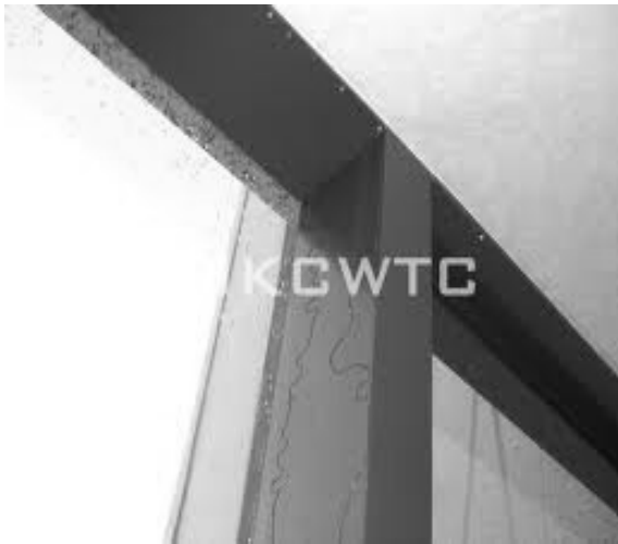
Hình 15.13: Lọt nước trên hệ vách kính
